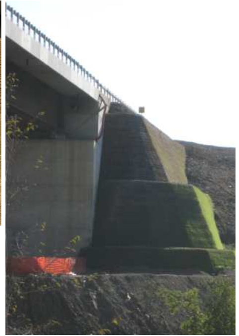
Particolare della chiusura della terra rinforzata in corrispondenza della spalla del viadotto;
