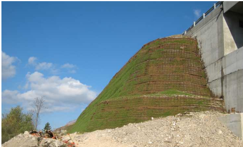
Particolare della chiusura della terra rinforzata in corrispondenza della spalla del viadotto;
